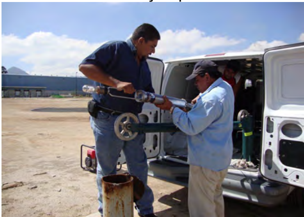
Instalación de la cámara para realizar videograbación en el pozo Cromatos 1.
