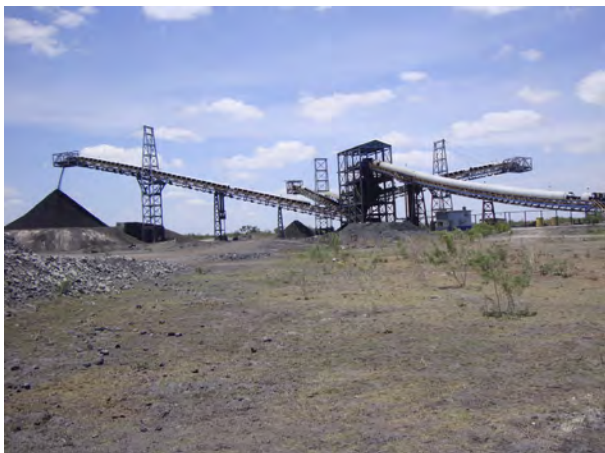
Extracción de carbón en mina.
