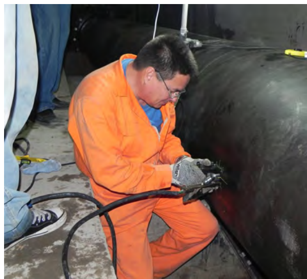
Instalación de un sensor de medición ultrasónico.
